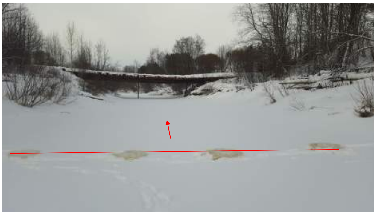
Фото 9. Река Луненка – створ перехода. Вид на мост.
